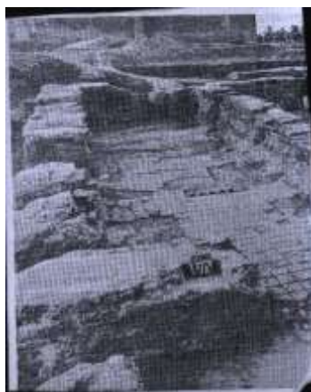
ملحق ٣- بقايا جدران دار الامارة في الكوفة يوضح استخدام الطابوق الفرشي في تبليط الارضيات
